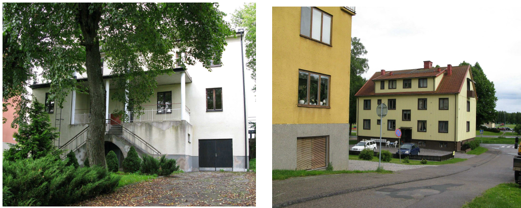
Fig. 5 Befintlig bebyggelse i kvarteret idag. Till vänster Berg 5 från söder och till höger ser man fastigheten Berg 16 från norr med Transtensvallen i bakgrunden.
