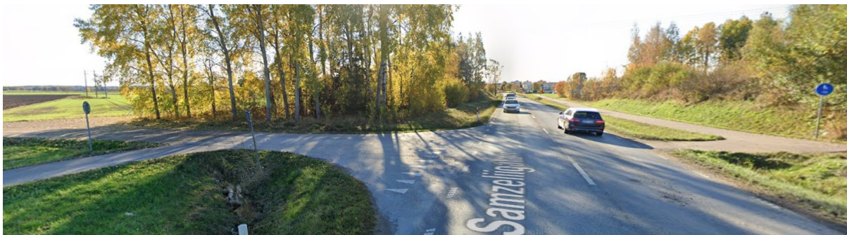
Figur 4. Bild av platsen där gång- och cykelbanan parallellt med väg 529 byter sida (Källa: Google Street View, 2023).
